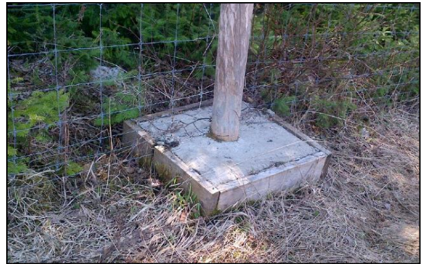
Figure 11 : Poteau de fixation en béton. Noter le fil de fond en béton
