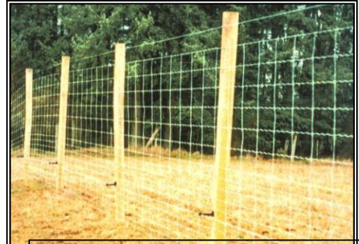
Photo 1 : Clôture en treillis de fils métalliques avec poteaux de bois et fil d'acier haute résistance dans la partie supérieure
