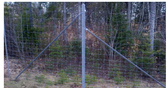
Photo 2 : Clôture en treillis de fils métalliques avec poteaux d'acier (3 1/2" po) / poteaux en T
