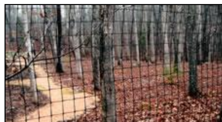
Photo 8 : Clôture en treillis de plastique
