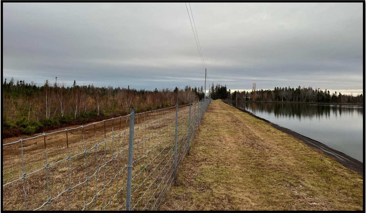
Photo no 3 : Végétation de talus
