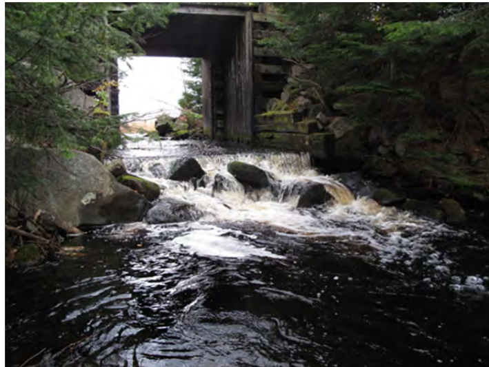
Photo 7.4.1 Structure faisant obstacle au passage du poisson à l'entrée du lac Nashwaak.
