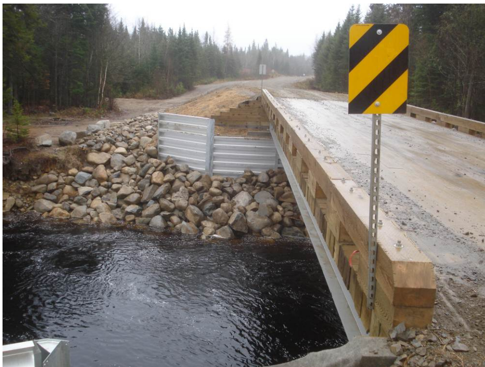
Photo 8.15.3 Nouveau pont à une seule travée et une seule voie sur la rivière Nashwaak.
