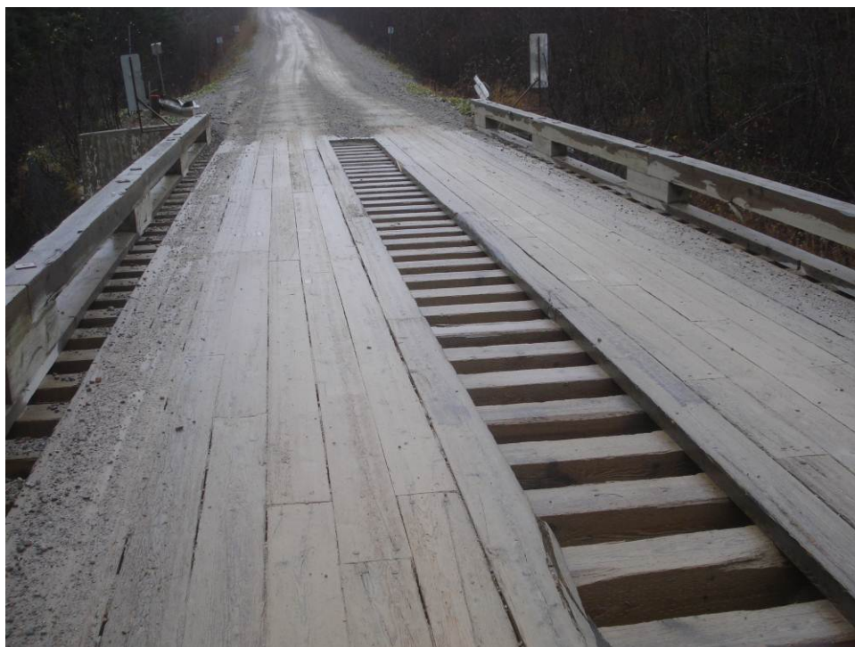
Photo 8.15.4 Pont à une seule travée et une seule voie sur la rivière Keswick.
