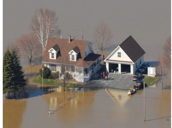
Une maison construite sur du remblai (lors d'un débordement de la rivière Saint-Jean)
