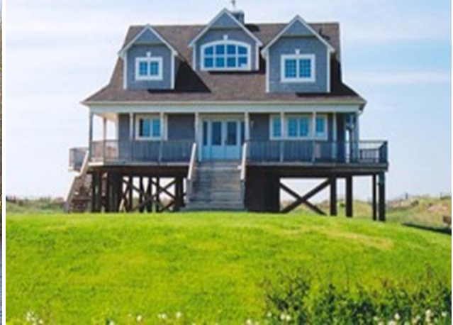
Une maison sur piliers donnant sur la mer à Robichaud (Nouveau-Brunswick)
