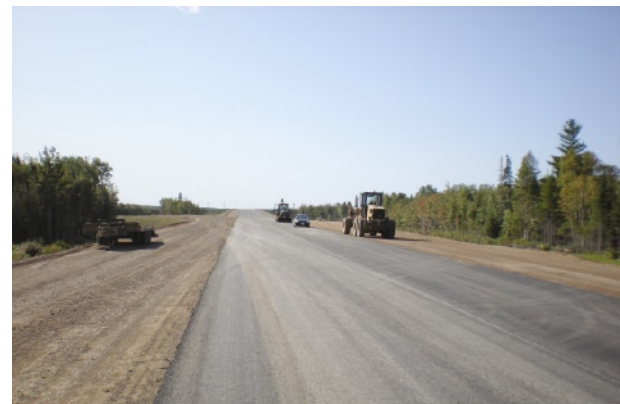
Voie de contournement de Tracadie, Du Nord, Route 11
